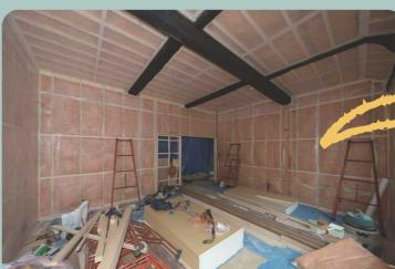
天井、壁共スキマなく断熱材を充填し、
