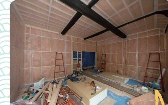
天井、壁共スキマなく断熱材を充填し、さらに気密シートをしっかり施工。
