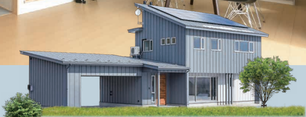
ヒートポンプ暖房 オール電化住宅
